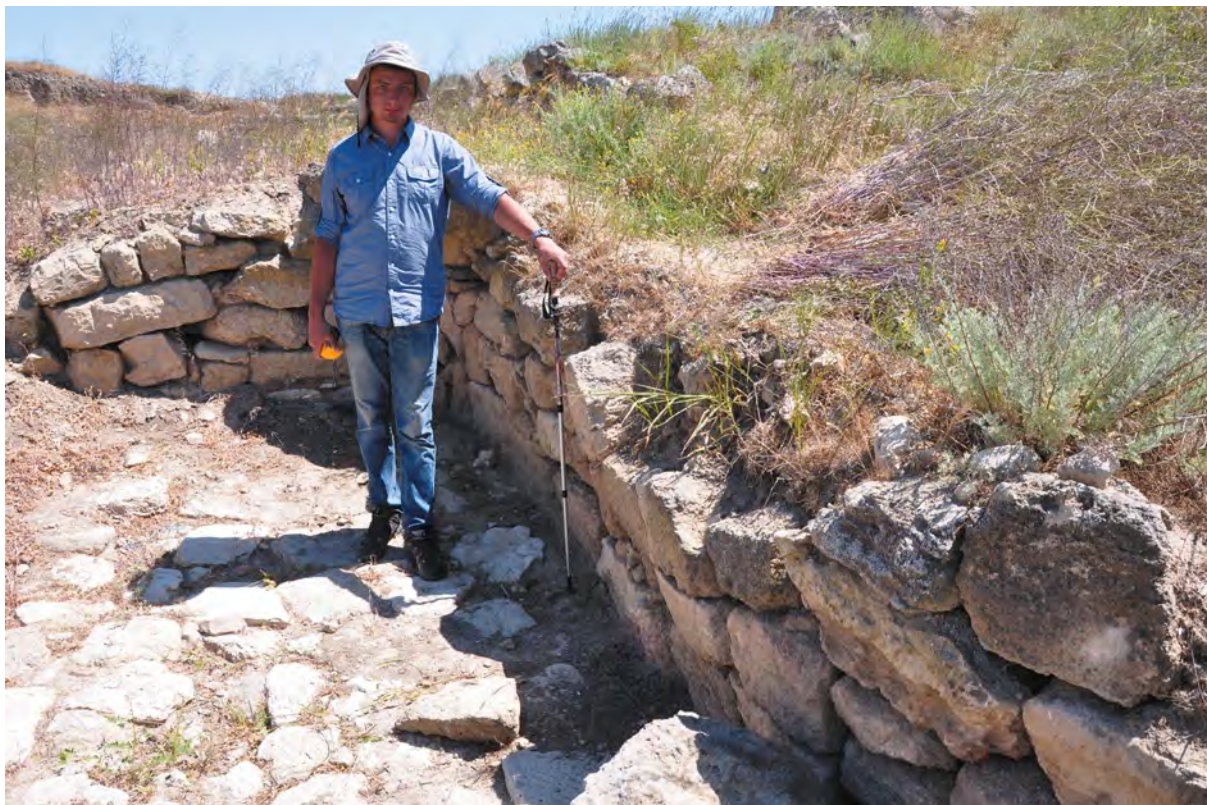
Рис. 23. Сильный наклон ( 75^\circ ) южной стены на север одного из помещений усадьбы I–II вв. н.э. На полу помещения сохранилась каменная вымостка, также деформированная. Фото 2018 г.
