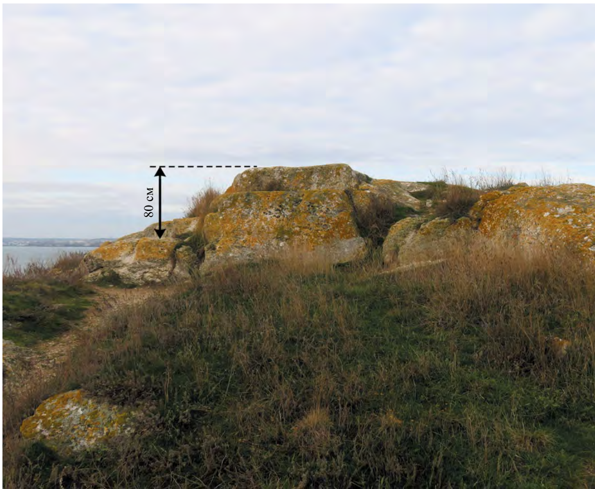
Рис. 29. Трещины субширотного простирания к востоку от «царской» гробницы (фото 2015 г., вид на запад)
