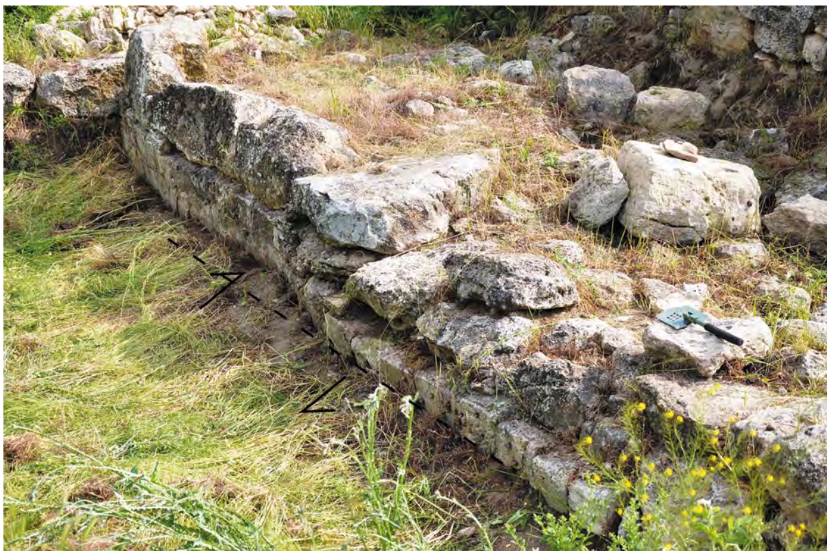
Рис. 10. Правосторонняя флексурная (в плане) деформация ранней оборонительной стены. Стрелками показано направления смещения. Пунктирная линия показывает исходное положение стены до смещения. Для масштаба – саперная лопатка в правой части снимка. Вид на СВ. Фото 2019 г.
