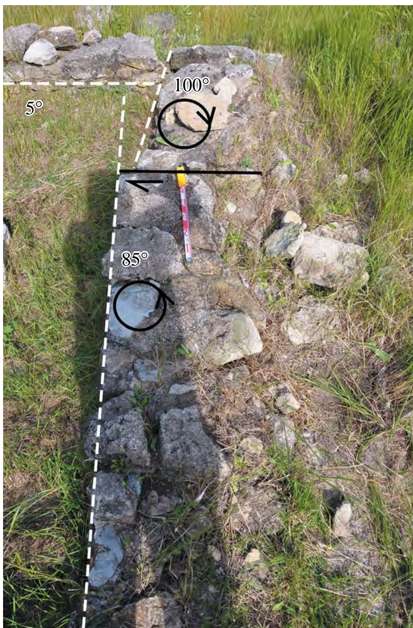
Рис. 14. Разворот против часовой стрелки субширотной южной стены «Святынища Деметры», раскоп «И». Вид на восток. Другой – восточный фрагмент стены, зацепившись, был также вовлечен во вращение. т.н. 19-2016
