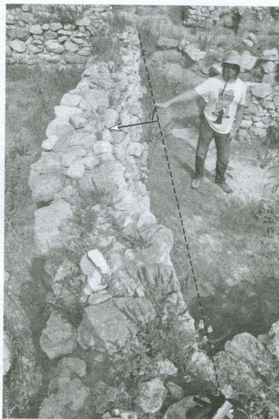
Рис. 10. Сильный дугообразный изгиб (в плане) и наклон на север одной из широтных стен на «Полянке»
