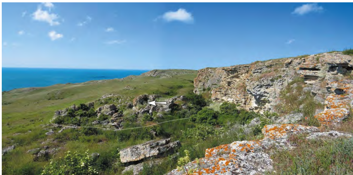
Рис. 29. Оползень-обвал на северо-востоке магистрального уступа
