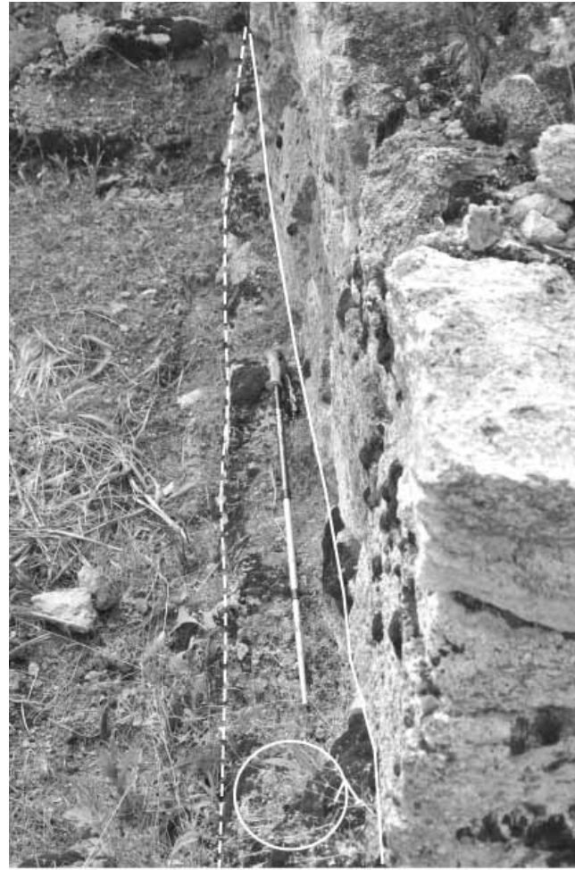
Рис. 8. Разворот против часовой стрелки верхних фрагментов субширотных стен близ северо-западной башни: а) – северная стена, северный фас, вид на восток; б) южная стена, северный фас, вид на восток. Сплошная линия маркирует современное положение развернутых фрагментов стен, пунктирная линия – их исходное положение до землетрясения.
