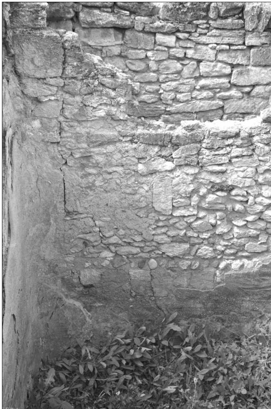
Рис. 10. Раскоп XXVI. Межблочная трещина в южной стене северной засолочной цистерны.
