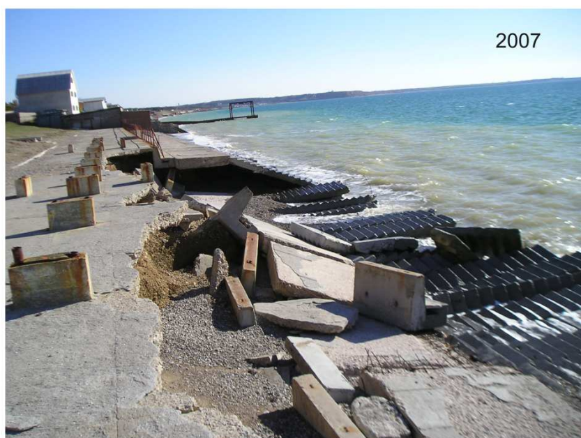
Рис. 2.1.2 Состояние берегоукрепительных сооружений в с. Песчаное в 2007 году
