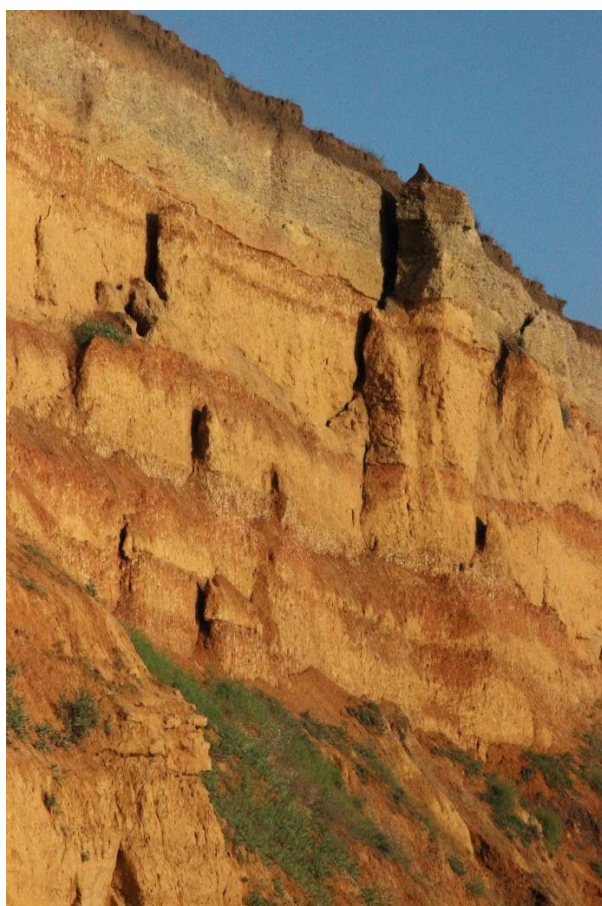
Рис. 12-7. Трещины бокового отпора на поверхности клифа в бухте Немецкая Балка.
