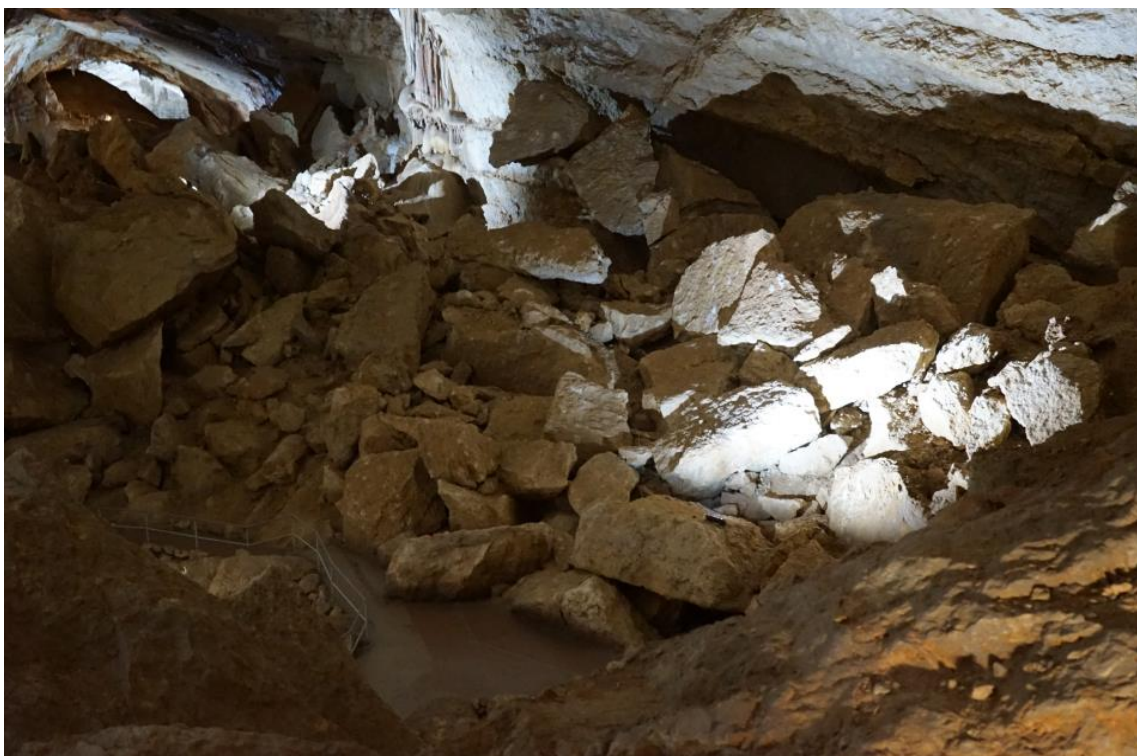
Рис. 19-4. Обвальный зал Перестройки, в пределах которого произошло обрушение свода Мраморной пещеры.
